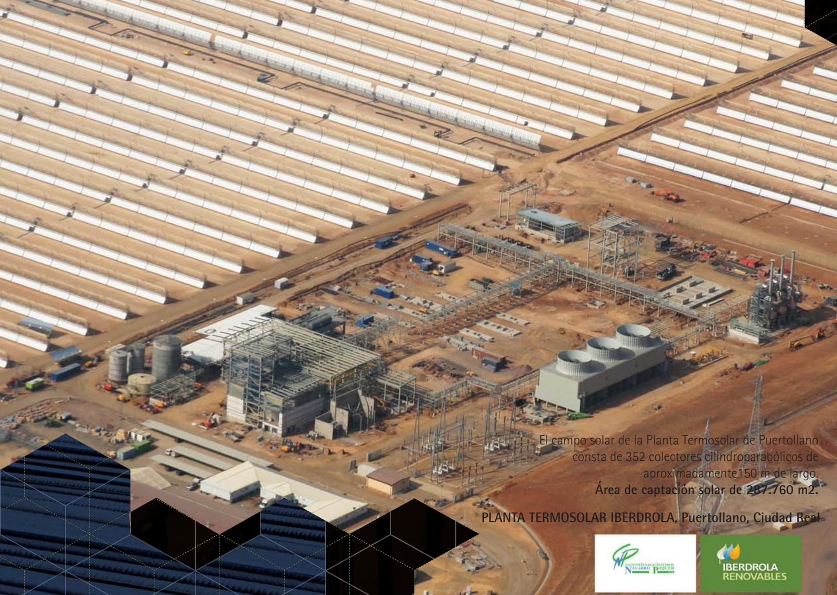
El campo solar de la Planta Termosolar de Puertollano consta de 352 colectores cilindroparábolicos de aproximadamente 150 m de largo. Área de captación solar de 287.760 m<sup>2</sup>.
